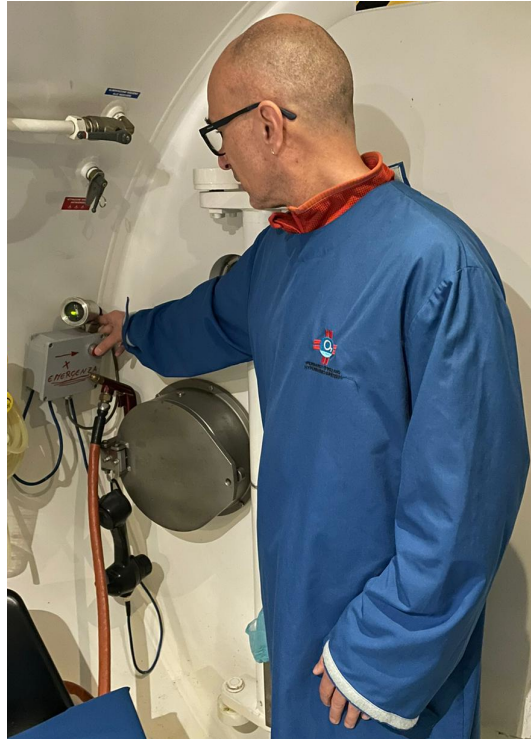
Figure 26. Pulsante per azionare l'allarme emergenza - by Ivan Zaro
