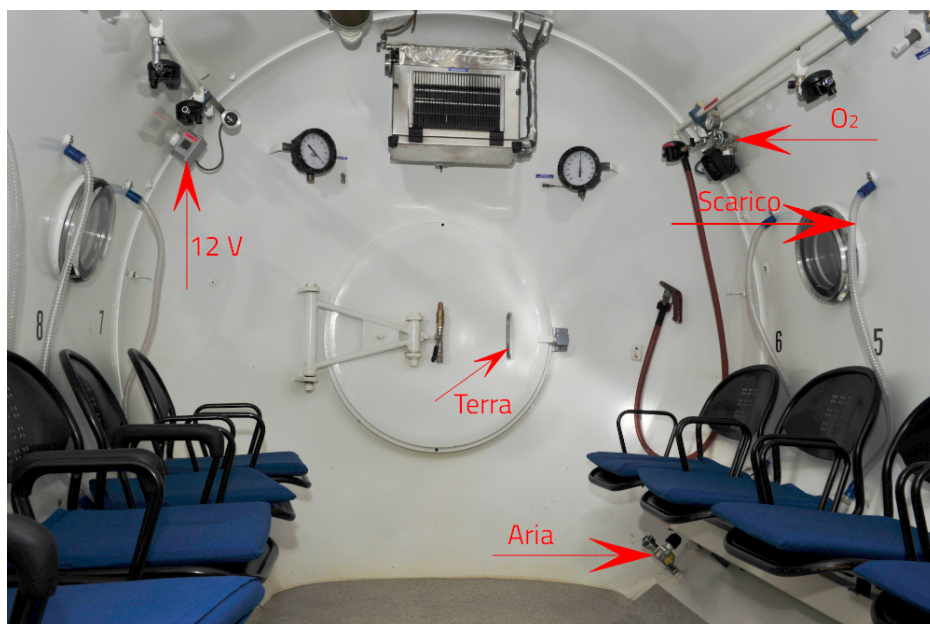
Figure 60. Punti di collegamento del ventilatore polmonare - by Andrea Congiu
