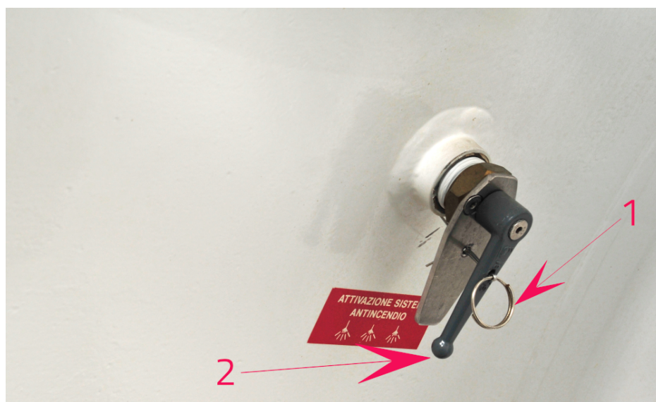
Figure 49. Comando di attivazione interno dei diffusori - by Andrea Congiu
