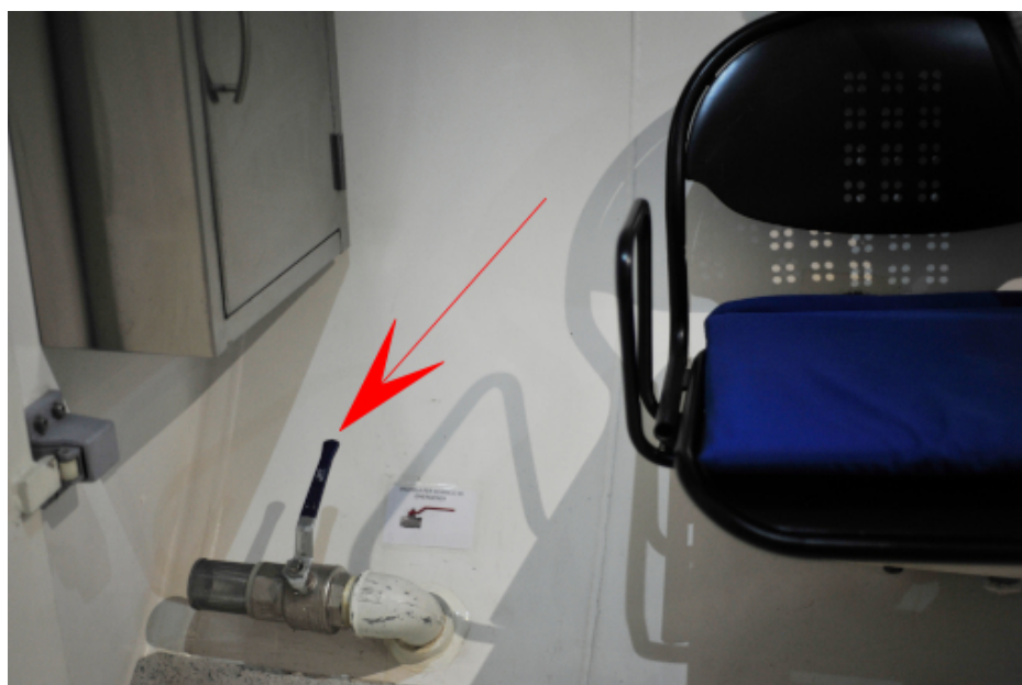
Figure 77. Valvola per lo scarico d'emergenza - by Andrea Congiu
