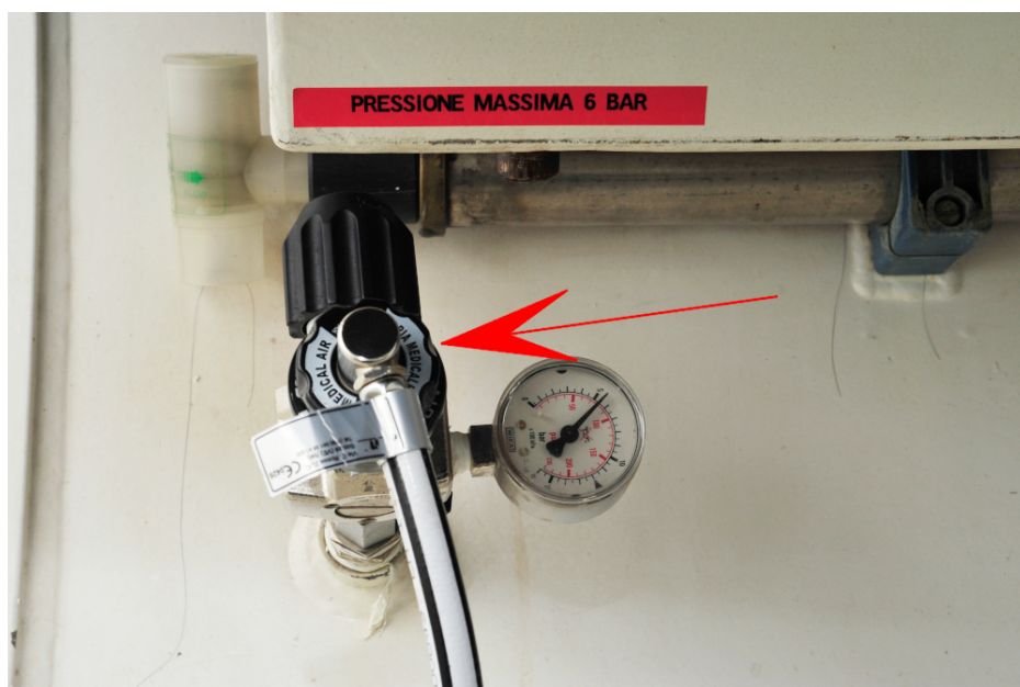
Figure 64. Collegamento del ventilatore polmonare alla linea aria - by Andrea Congiu
