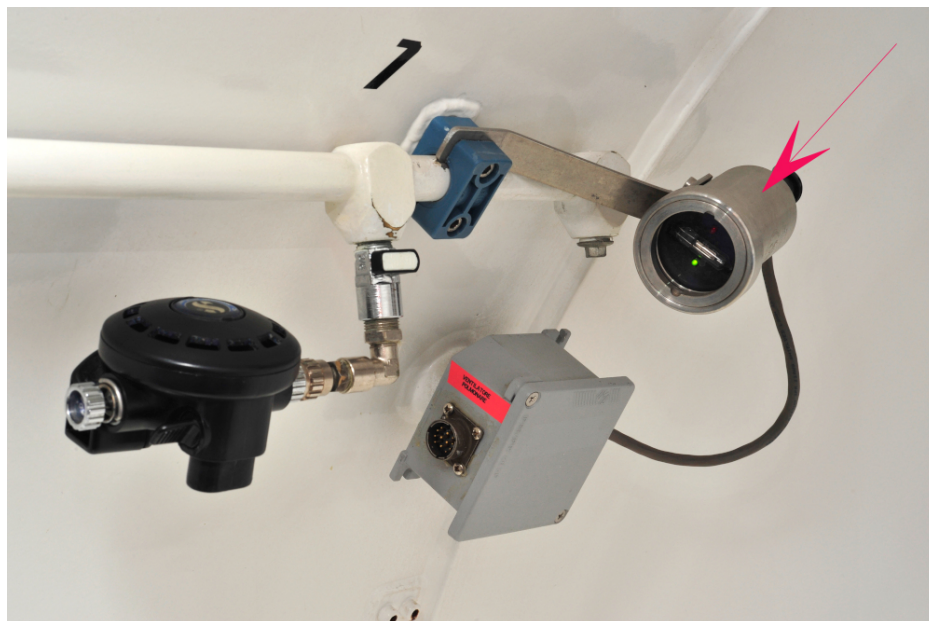
Figure 46. Rilevatore di fiamma - by Andrea Congiu
