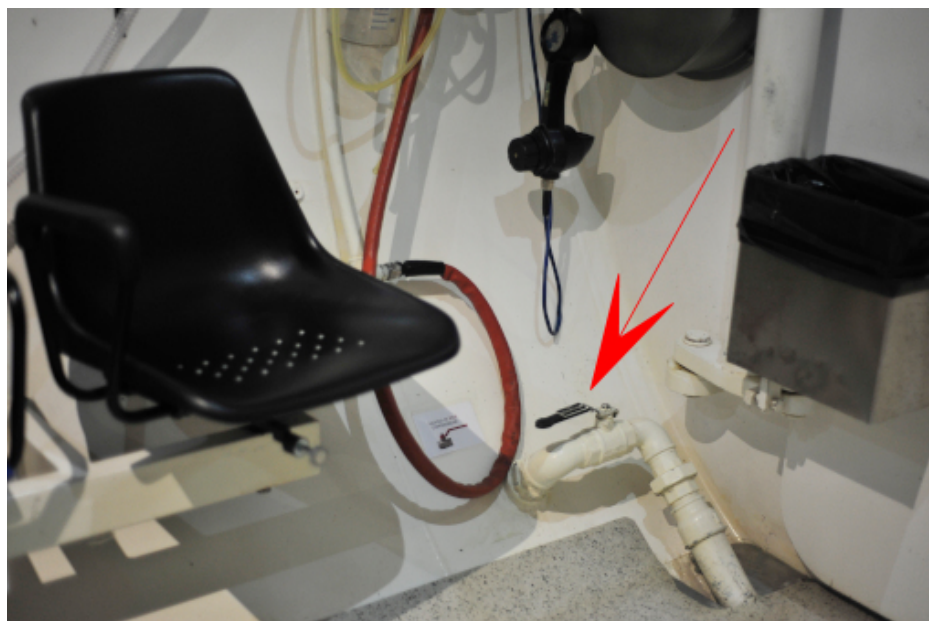
Figure 76. Valvola di stop compressione - by Andrea Congiu
